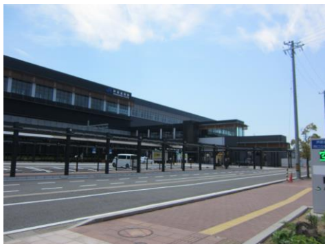
新装なった北の玄関口 芦原温泉新駅舎
